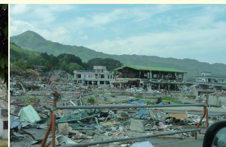
壊滅的な被害を受けた山田町
